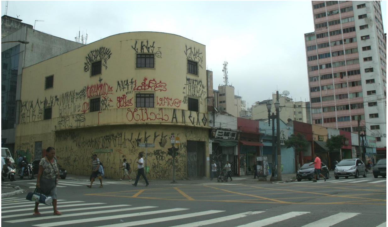
IMÓVEIS SUBUTILIZADOS NA AV. RIO BRANCO, ESQUINA COM R. DOS TIMBIRAS. FONTE: SP Urbanismo, 2016.
